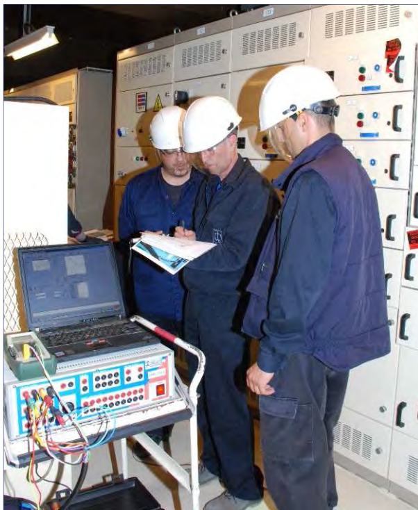
Revisión eléctrica de redundancia 4/8
