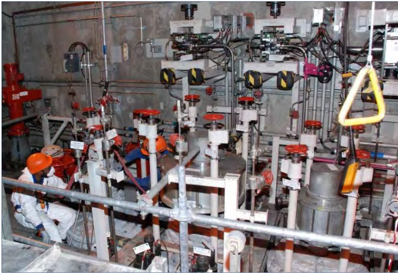
Revisión de válvulas vapor principal lazo 10
