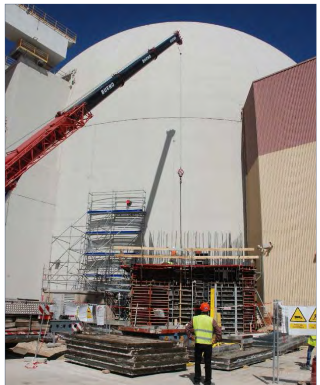
Instalación del Sistema de Venteo
