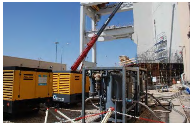
Prueba de presión del recinto de Contención
